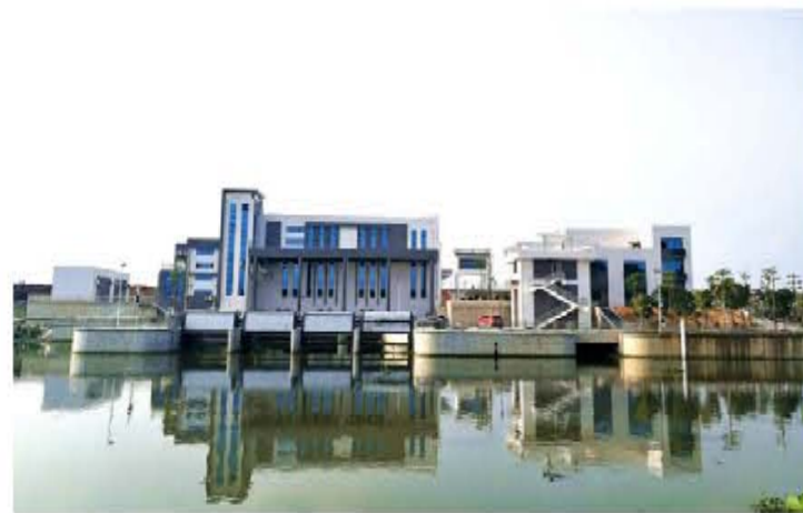
优质工程奖——高明区三洲北泵站新建工程
