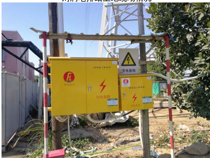
城西泵站工地现场施工用电情况
