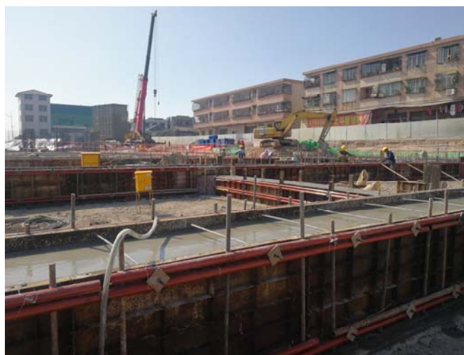
太平排涝泵站工地现场情况
