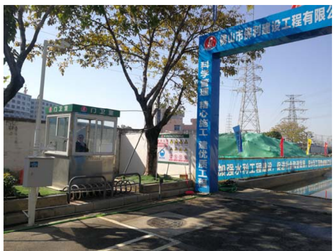
城西泵站工地入口文明施工设施情况
