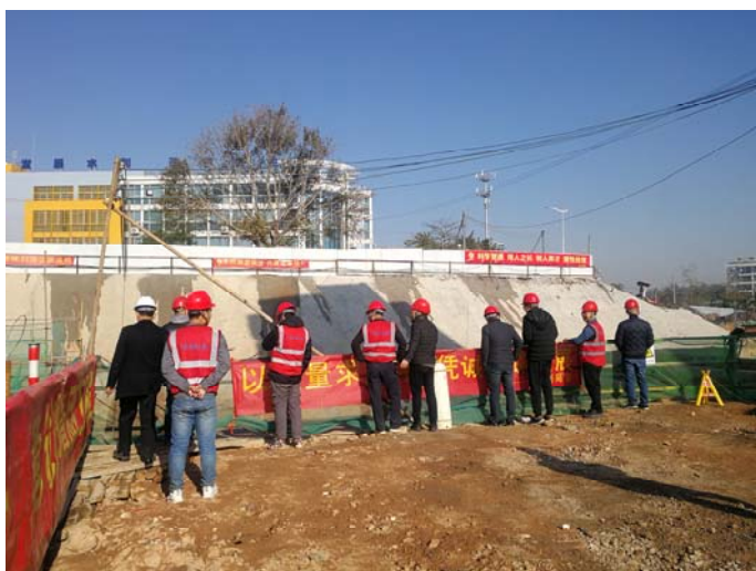
刘洞电排站工地现场情况
